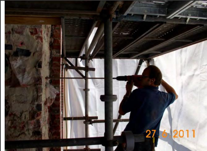
Bohrvorgang mit Auffangen des Bohrmehls in Tüten.
