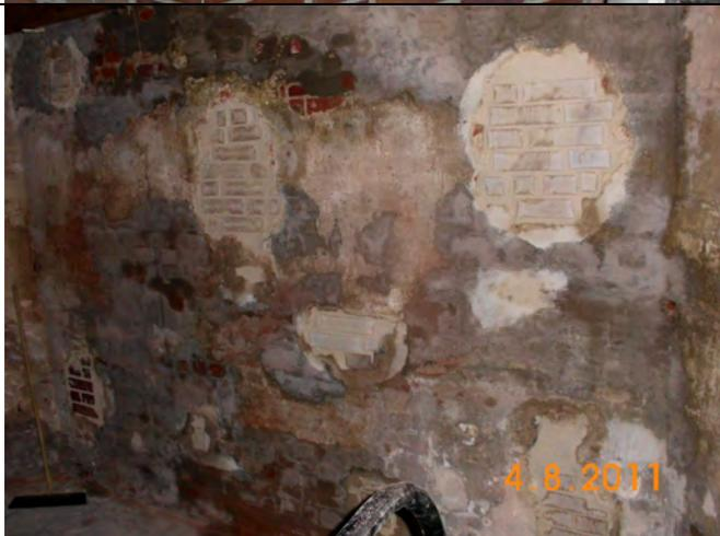
Ausgemauerte Öffnungen von Hohlräumen und früheren Stahlträgern auf der Innenseite der Westwand in der Ebene unterhalb der Turmuhr.
