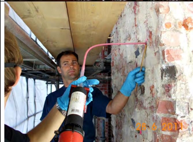
Verfüllen des Bohrloches mit Injektionsmörtel.
