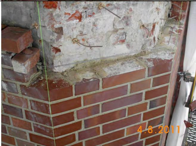
Edelstahlanker in jeder 3. Lagerfuge im Bereich der Turmecken unterhalb der Wasserspeier.
