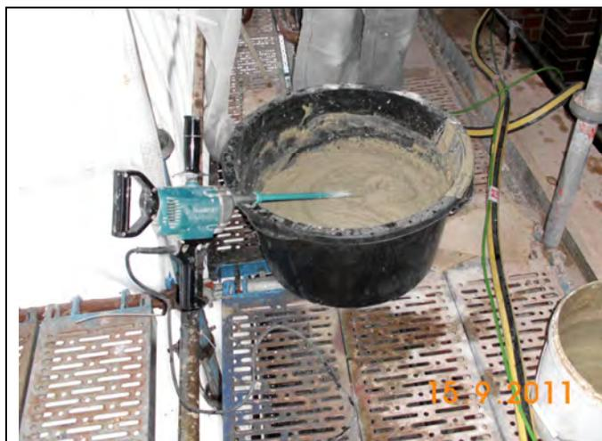
Mörtel für die maschinelle Verfüzung der neuen Vormauerschale.
