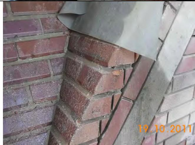
Der Ortgang des Giebels über dem Haupteingang bestand ursprünglich aus Formsteinen und wurde später mit Kupfer eingefasst. Die Abdeckung wurde erneuert.
