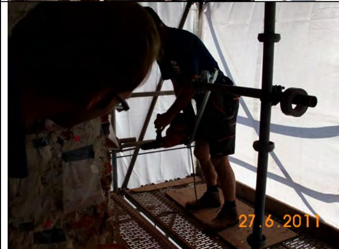
Erster Bohrabschnitt (50 cm) mit Bohrlehre am Gerüst.
