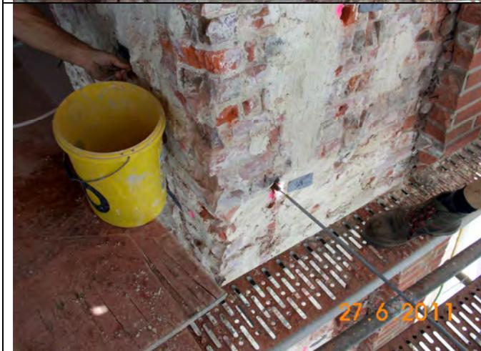
Bohrlochreinigung mit Druckluft links und Bürstenkopf rechts.
