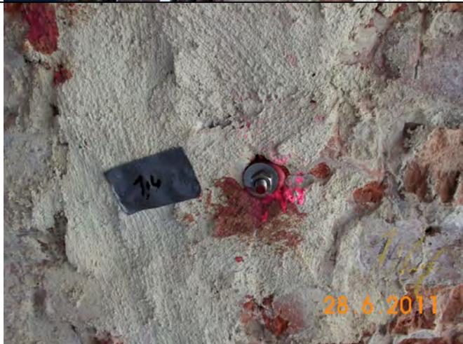
Ankerkopf mit Schraube und Mutter.
